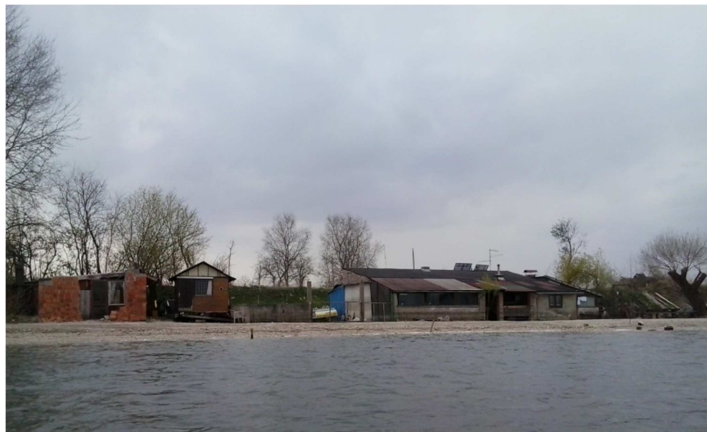
Slika 4: Primjer nelegalne gradnje uz obalu na južnoj strani obale jezera Šoderica
